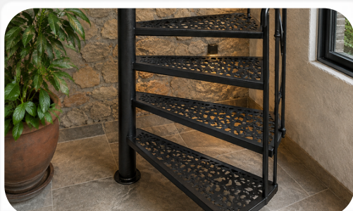
ACCESOS Y ESCALERAS
